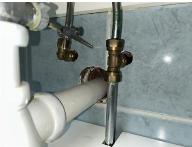
Dusch/wc: Otätheter under kommod.
