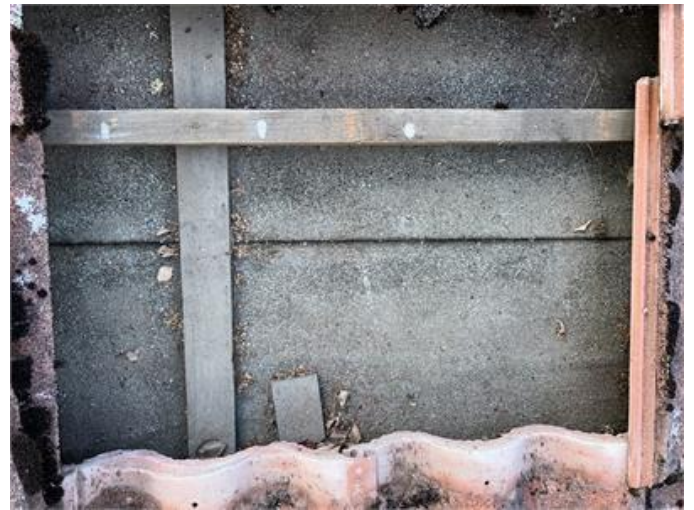
Tak: Stickkontroll under pannor med anmärkning torr papp.
