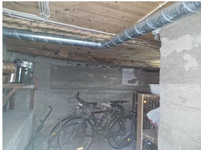
Torpargrund, grovkällaredel söder.
