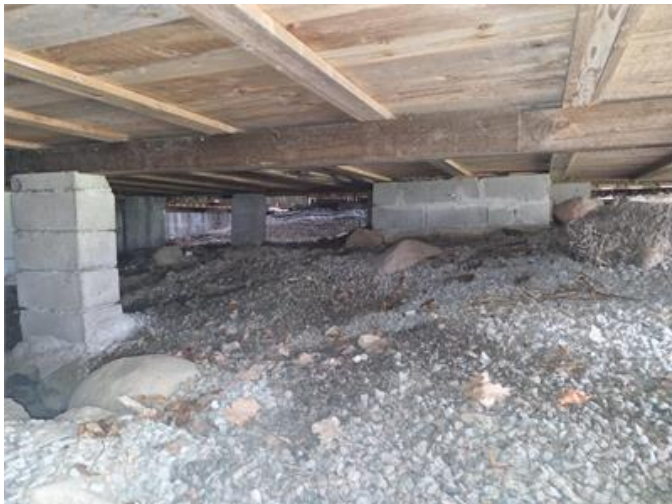
Plintgrund ursprunglig del, översiktsbild.
