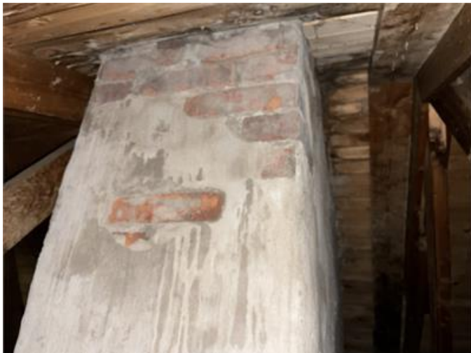
Nockvind: Mindre putssläpp finns upptill på murstock.
