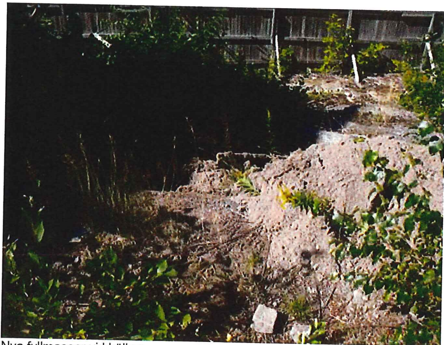
Nya fyllmassor vid källare
