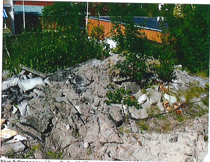
Nya fyllmassor vid nedbränd källare
