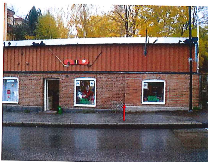
Synsamhuset på fastigheten Krukan 4. Inlagd pil markerar gräns mellan gammal (till vänster) och ny del (till höger).
