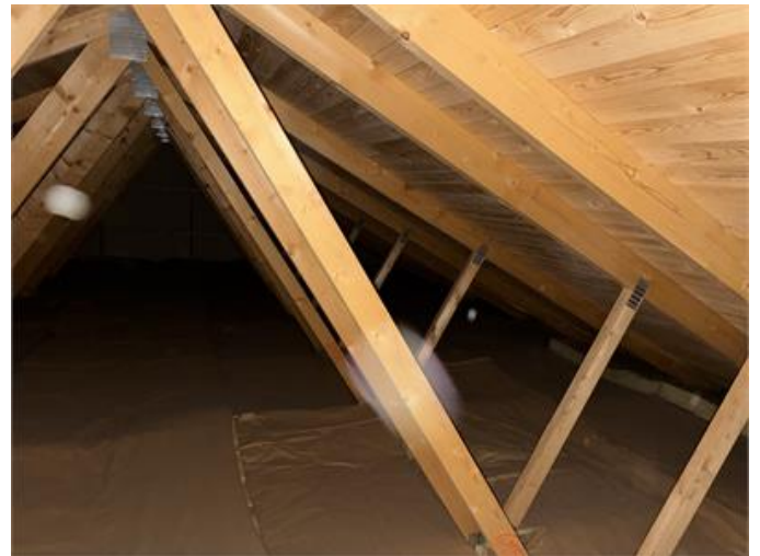
Nockvind tillbyggnad: översiktsbild.
