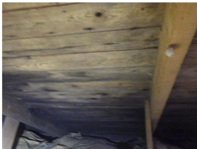
Mikrobiell påväxtnockvind.
