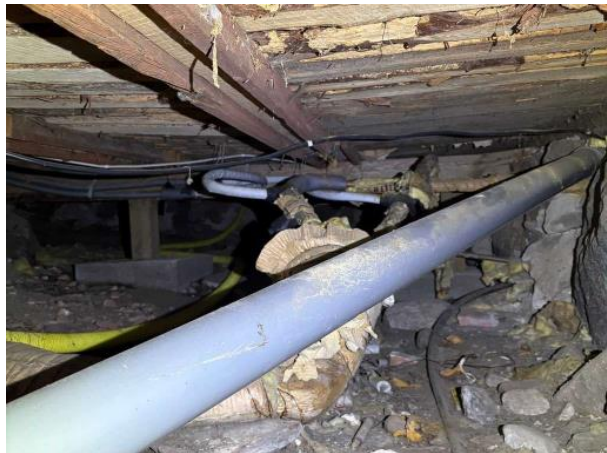
Bild 2: Utvändigt, Grund, Kryp-/torpargrunden. Balk bägnar
