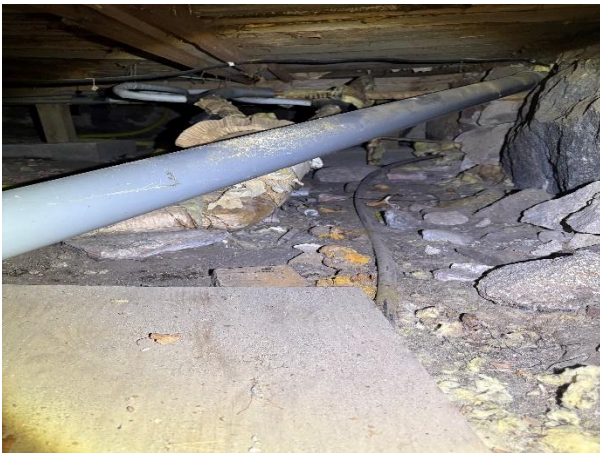
Bild 1: Utvändigt, Grund, Kryp-/torpargrunden, se riskanalysen. Grunden är besiktad ca 3 meter in från luckan (trångt utrymme)
