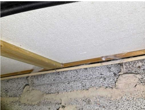
Bild 3: Utvändigt, Grund, Tilläggsisolerat bjälkalg
