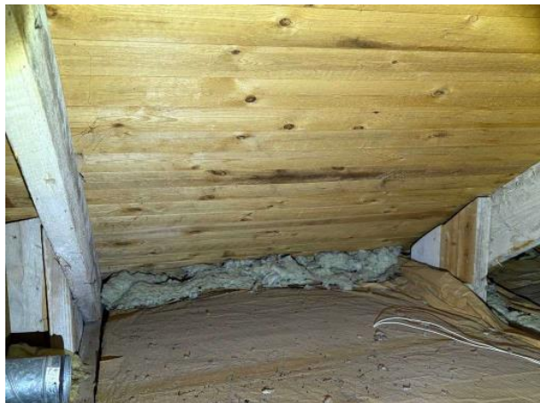
Bild 4: Utvändigt, Vind, Isolering ligger dikunderlagstaket
