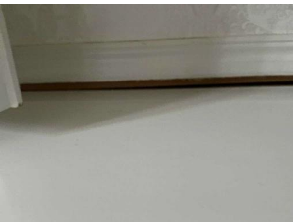
Bild 5: Invändigt, Entréplan, Matrumsdel. Glipa noterades mellan golv och sockel (detta fanns vid förvärvet och har inte förändrats sedan dess)
