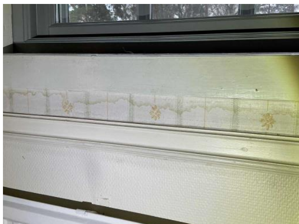
Bild 9: Invändigt, Entréplan, Sovrum 2, Fuktfläckar under fönster (torrt vid besiktningsstillfället) Ordnad tilluft saknas
