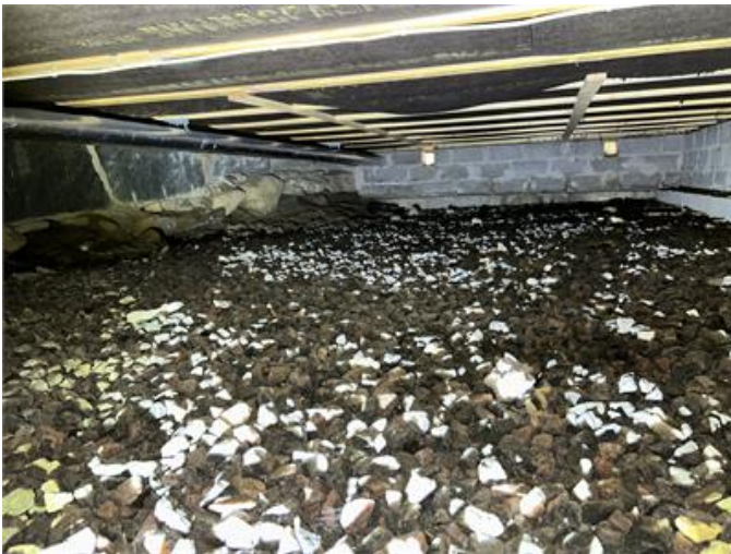
Krypgrund östdel: Översiktsbild
