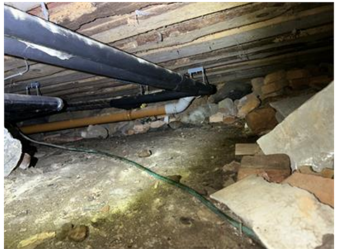
Krypgrund norrdel: Översiktsbild
