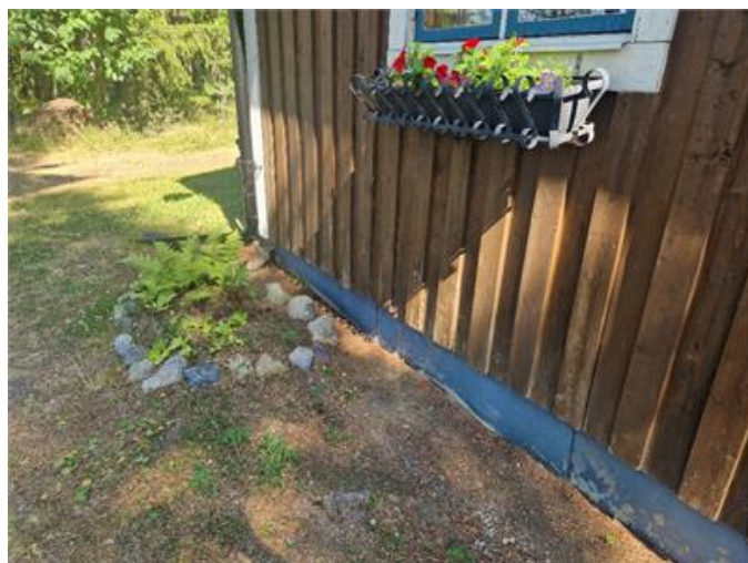
Fasad, sockel och fönster
