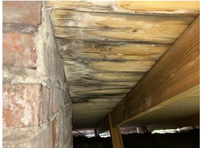
Nockvind: Fuktanvisning på underlagstaket vid bl.a. murstock
