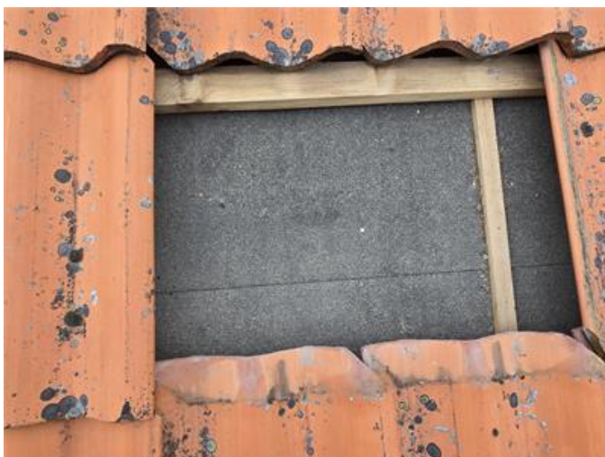
Tak: Stickprovskontroll under pannnor.
