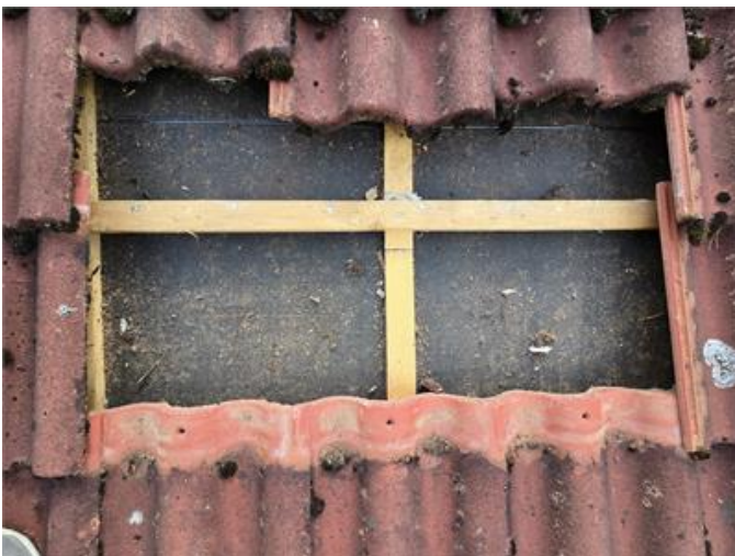
Tak: Stickprovskontroll under pannnor.
