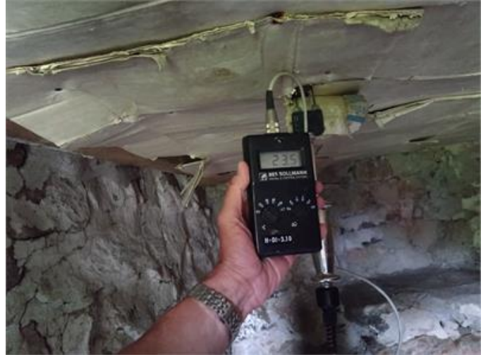
Fuktmätning i grund ett
