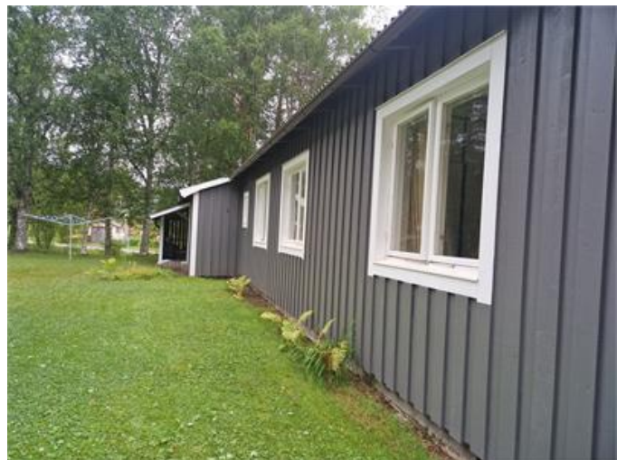
Fasad och fönster.
