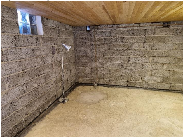
Bild 1, Källare, tidigare inredd.
