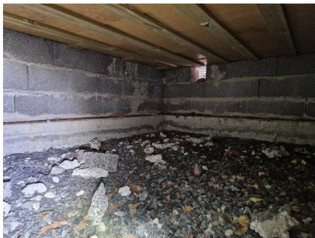
Bild 8, Vy krypgrund, nyare del.
