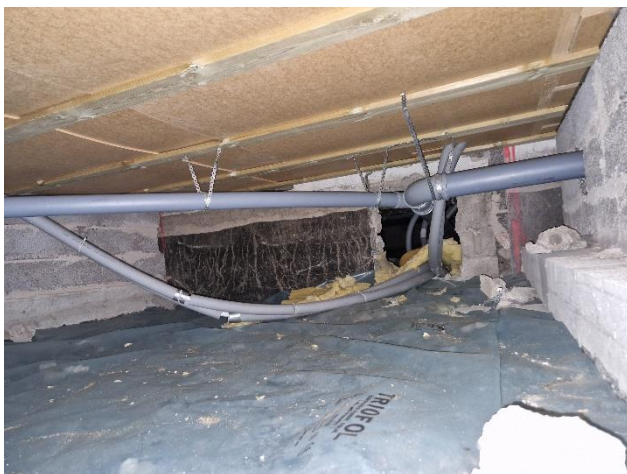
Bild 7, Vy krypgrund, nyare del mot äldre grundmur.
