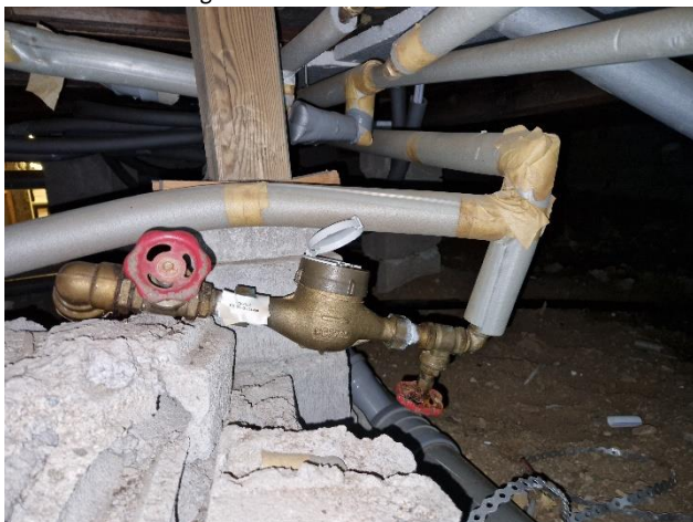
Bild 3, Kondens på vattenmätare
