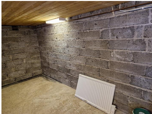
Bild 2, Källare, tidigare inredd.
