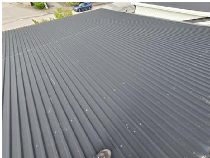
Tak: Översiktsbild Tak mot norr
