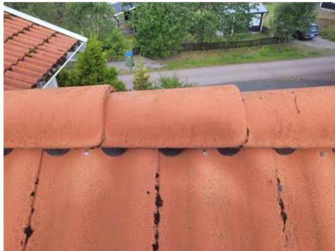
Synliga infästningshål
