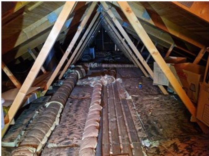
Vy på vindsutrymmet
