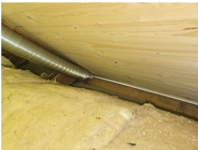
Bilden visar avluft från våtrumsfläkt på övre plan.
