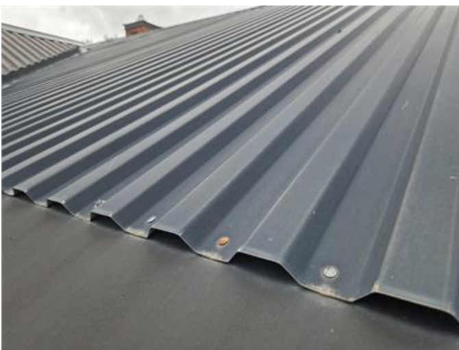
Pappspik noters som infästningar på/av aluminiumplåt.
