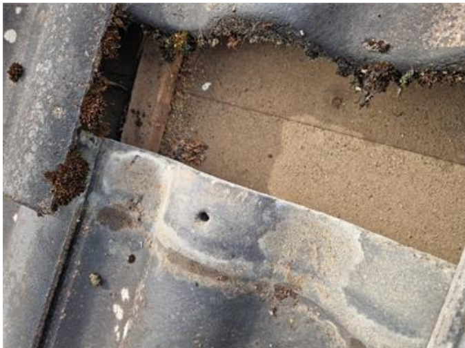
Vy på underlagstak
