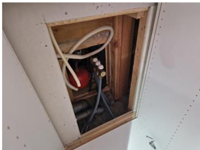
Shuntgrupp för värmen finns i garderob i sovrum/entréplan.
