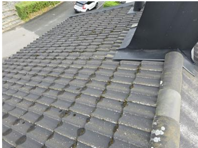
Överblick del av yttertak.
