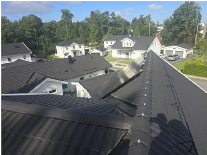
Översiktsbild, delar av yttertak.
