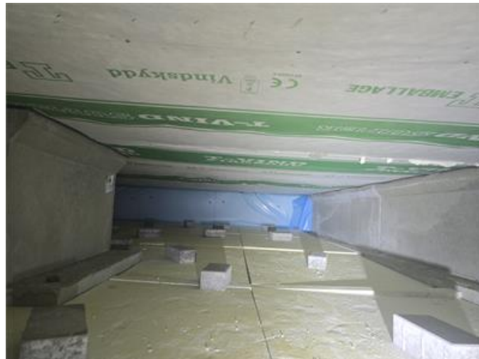
Översiktsbild, del av varmgrund.
