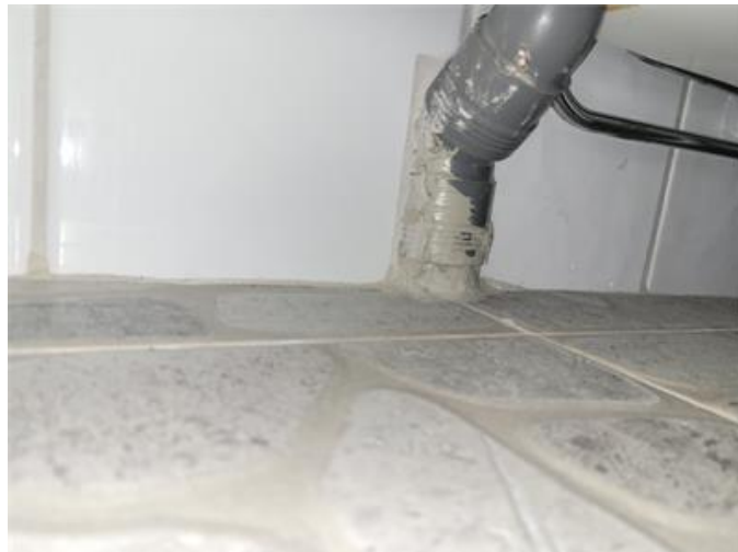
Avloppsinstallation nära vägg
