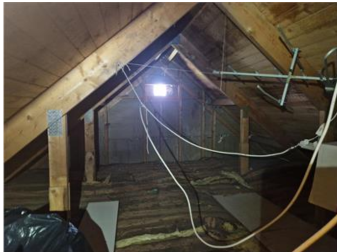
Vy på vindsutrymmet
