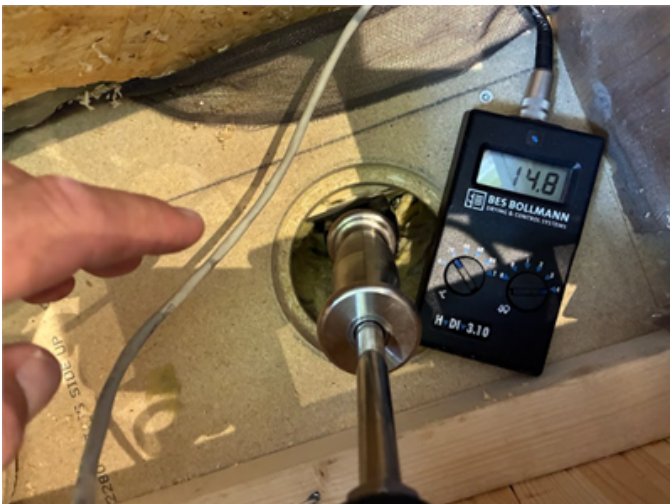
Bilden visar fuktkvotsmätning i golvkonstruktion i kök. Gränsvärde är 17%.
