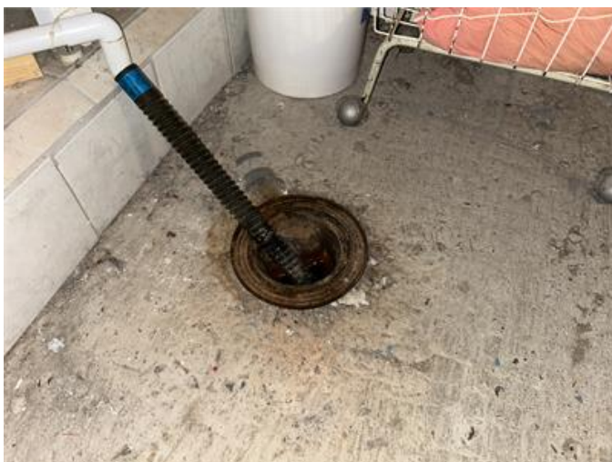
Källare: Golv under renovering och där med är golvbrunnar högpunkt.
