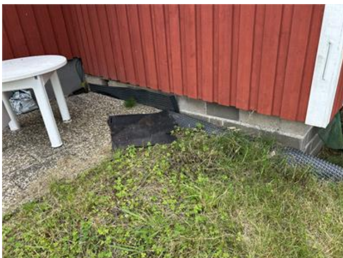
Mark: Platonmatta synlig på grundmuren under bl.a. uterum.
