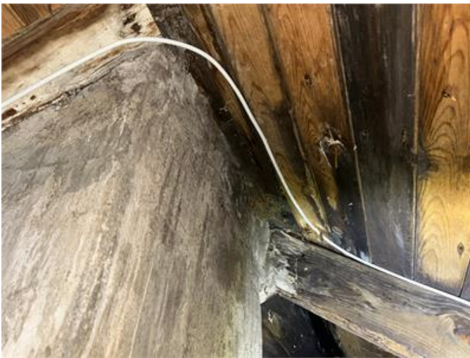
Nockvind: Fukktanvisning runt bl.a. murstock.
