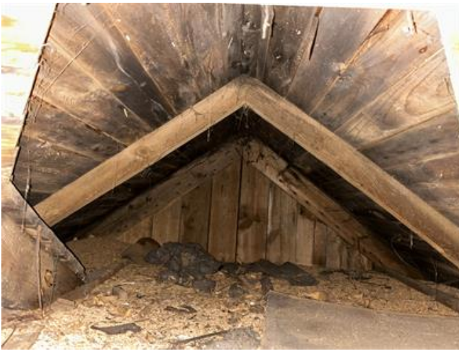
Nockvind vinkeltak: Översiktsbild.
