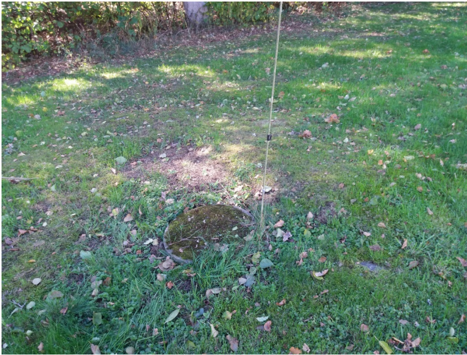
Bild 3 – Det finns ett betongrör (”fördelningsbrunn”) mitt i gräsmattan.
