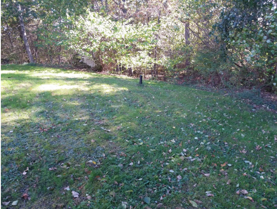
Bild 5 – Luftningsrör som markerar platsen där stenkistan finns.
