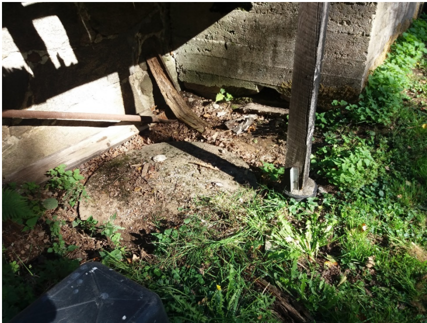
Bild 1 – Placering av slamavskiljare väldigt nära bostadshuset
