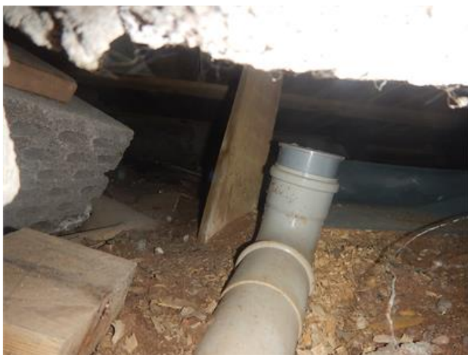
Bild torpargrund, ej besiktningsbar del.
