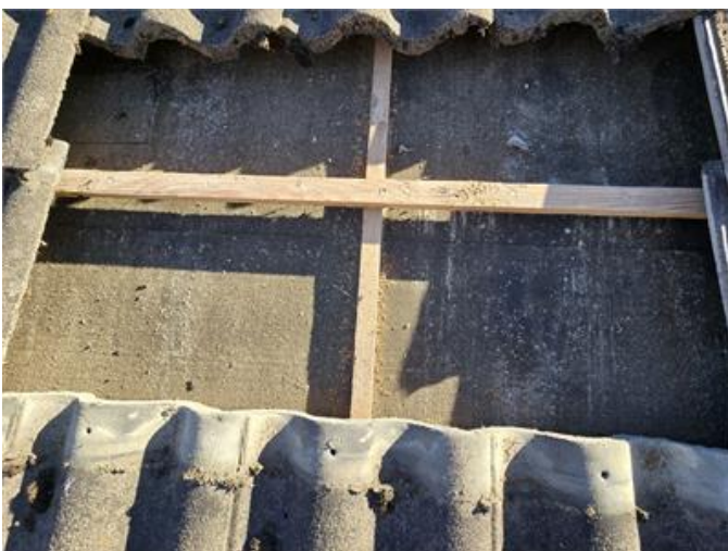
Stickprovskontroll under pannor på Tak.
