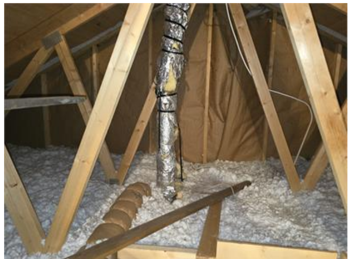
Översiktsbild Nockvind mot väst.
