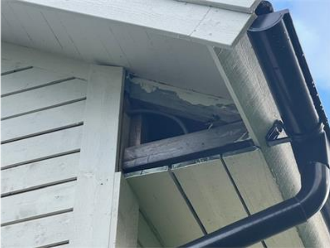
Bilden visar exempel på otätheter/brister i simslådan.
