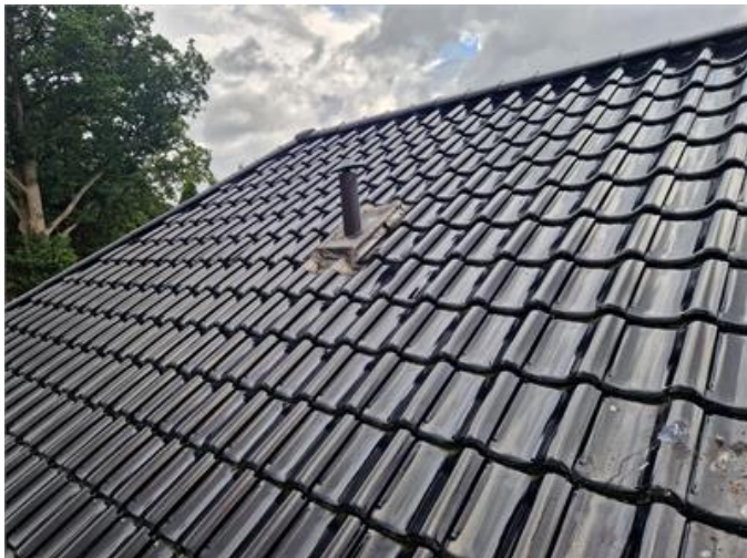
Vy på yttertak
