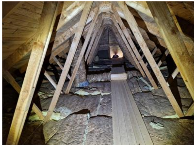
Vy på vindsutrymmet
