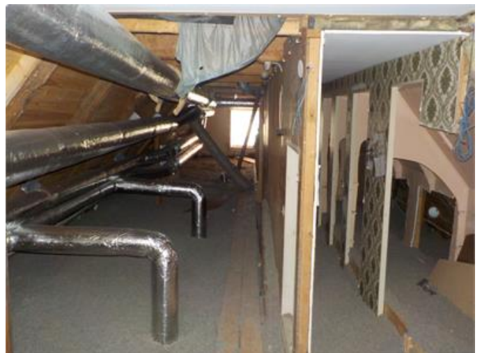
Ursprunglig vind där rester av bl.a. tidigare väggar finns kvar.
