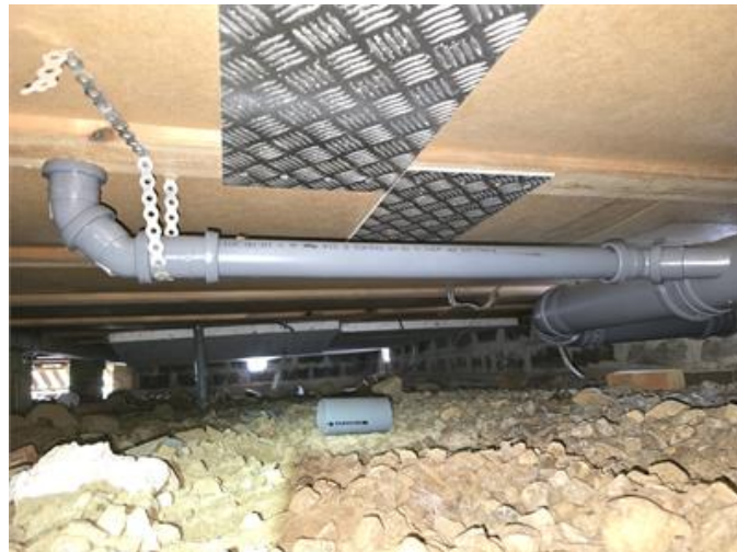
Plintgrund: Översiktsbild under Dusch/Wc.
