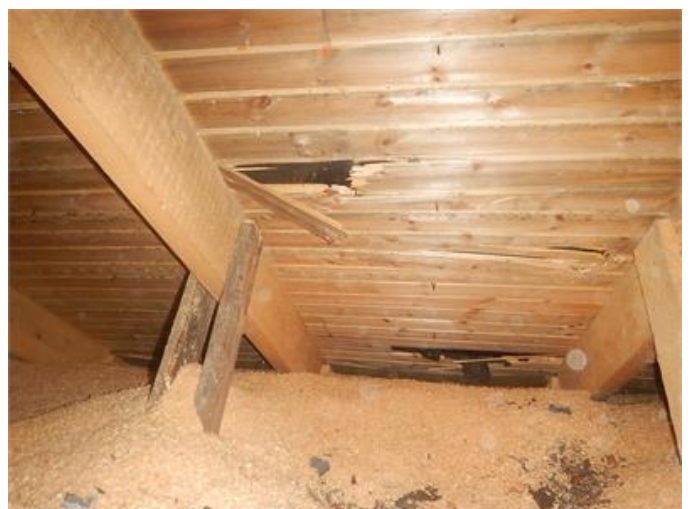
Råspont som är knäckt på underlagstak.
