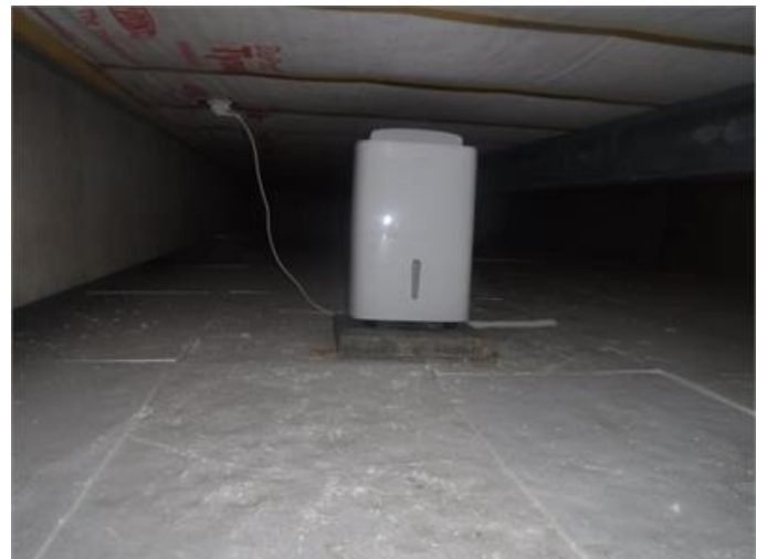
Krypgrund: Huset är uppbyggt på en varmgrund, se vidare under kommentarer och riskanalys på sida 4.
