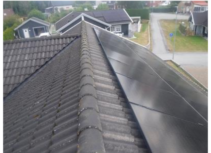
Tak: Bostadshuset har ett sadeltak klätt med betongpannor och har undertak av Masonit, carporten har ett undertak av trä och underlagsduk.
