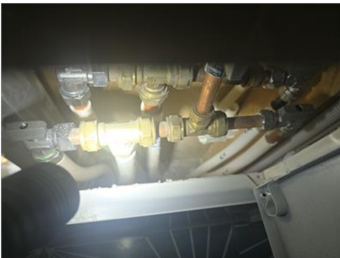
Rörkopplingar inbyggd i vägg bakom inspektionslucka, dusch/wc, entréplan.
