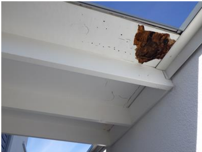
Rötskada underlagstak.
