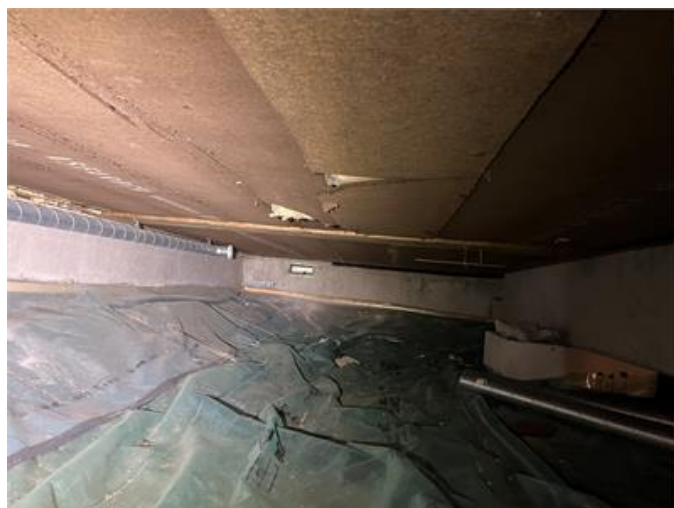
Bild från krypgrunden.
