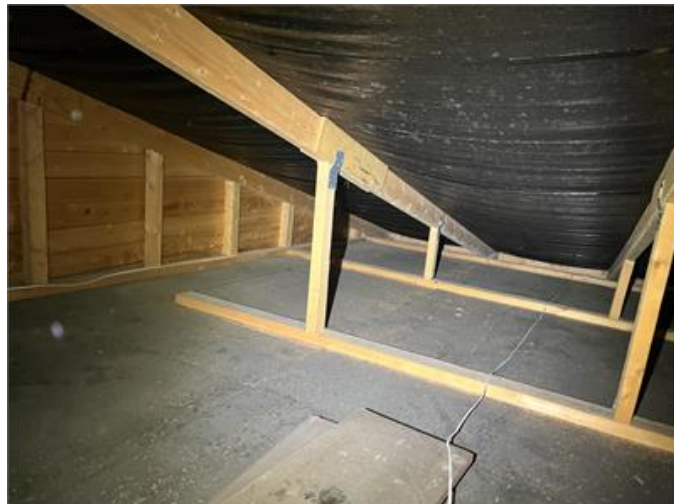
Bilden visar del av vinden.
