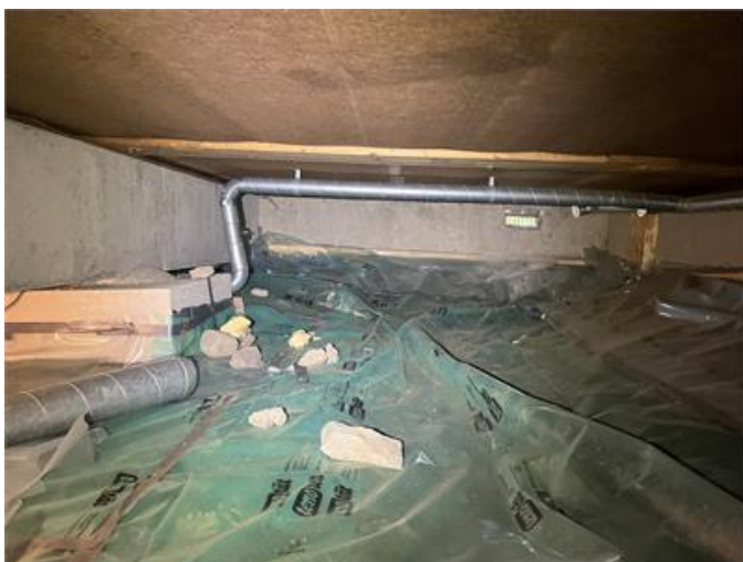
Bild från krypgrunden.
