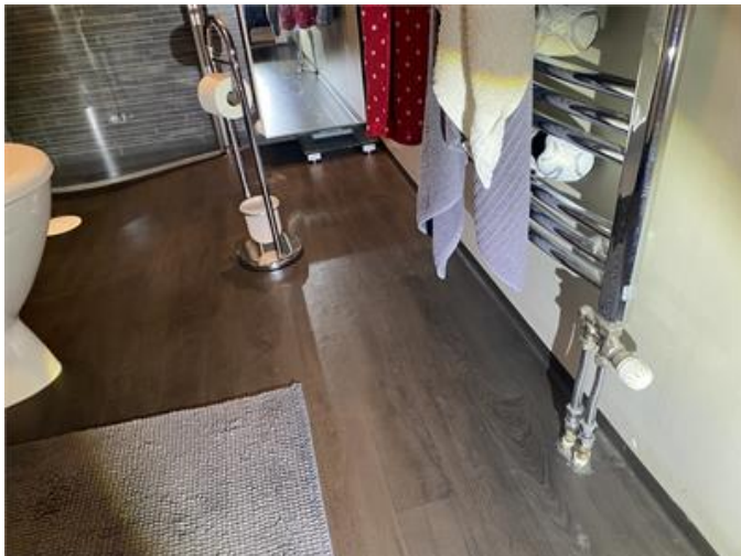
Rör genomföringar i golv
