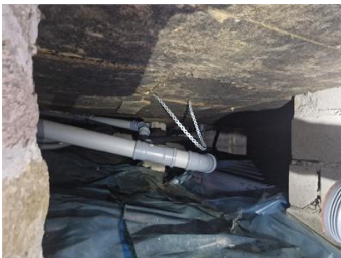
Vy i krypgrund
