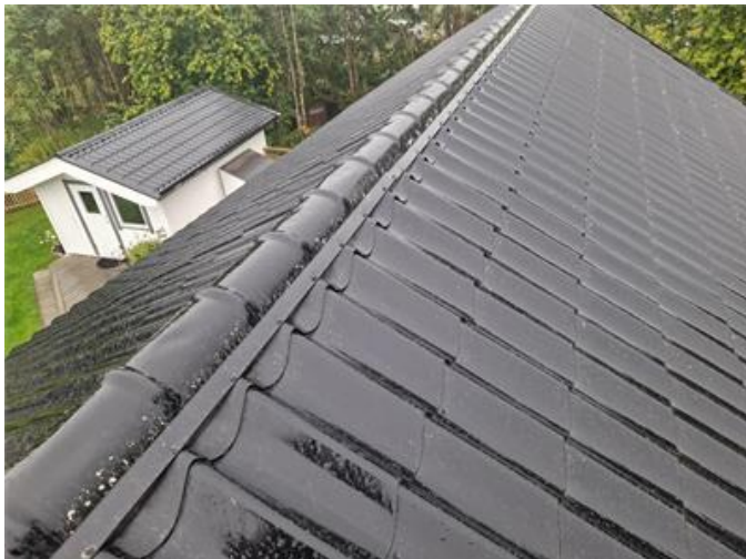
Vy på yttertak
