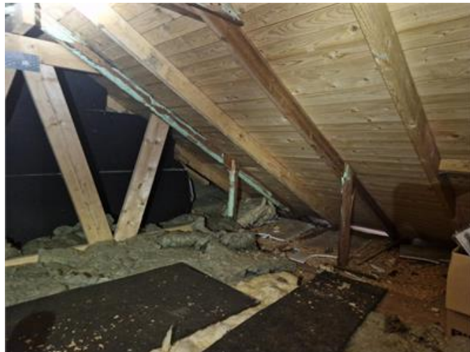
Vy på underlagstak
