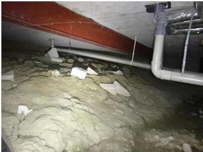
Bilden visar vy av krypgrund.
