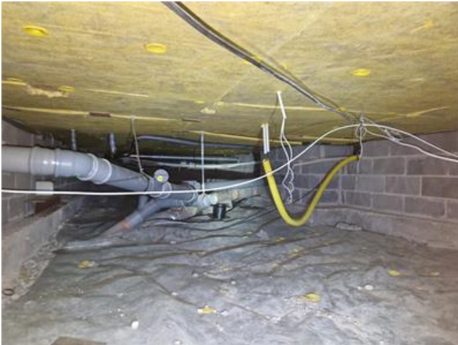
Krypgrund, översiktsbild ursprunglig del.
