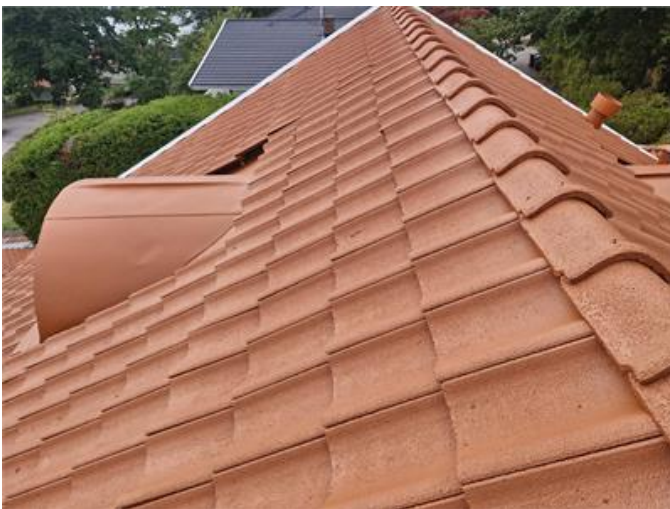
Tak, original med tvättade och målade takpannor.
