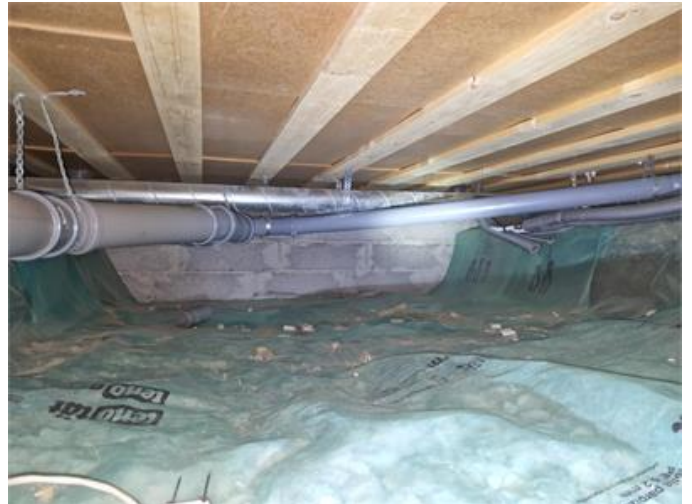
Krypgrund, översiktsbild utbyggnad söder.
