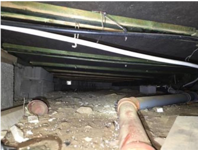
Krypgrund: Översiktsbild mot väst, oisolerade vattenrör.
