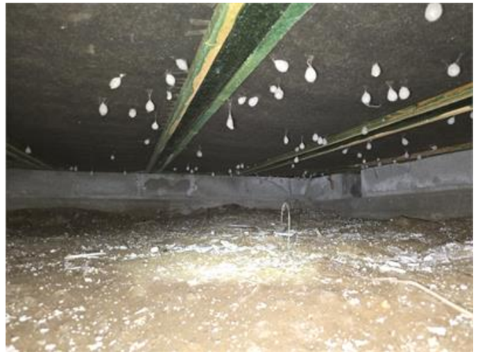
Krypgrund: Översiktsbild mot norr.
