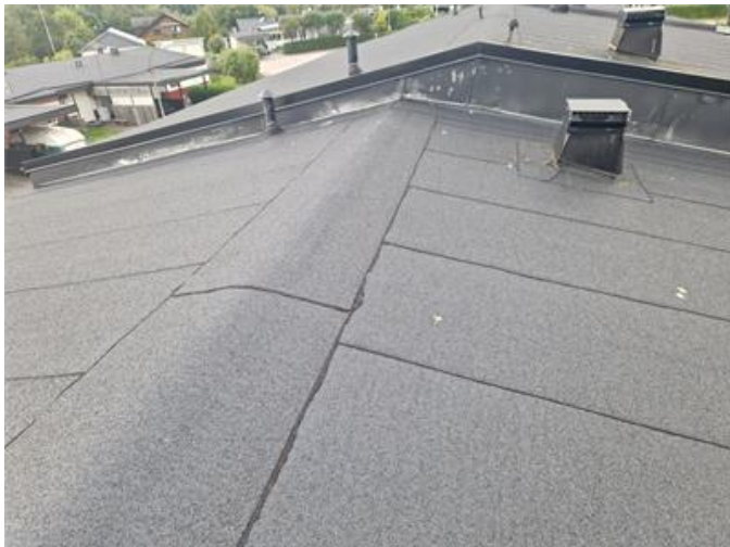
Vy på yttertak
