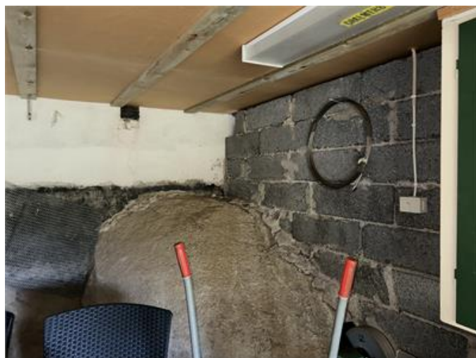
Garage: Berg kommer fram.
