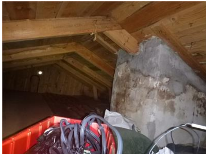
Bilden visar vy av vind.
