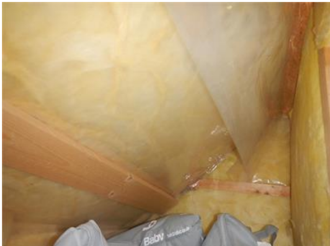
Otätthet i diffusionsspärr sidovind.
